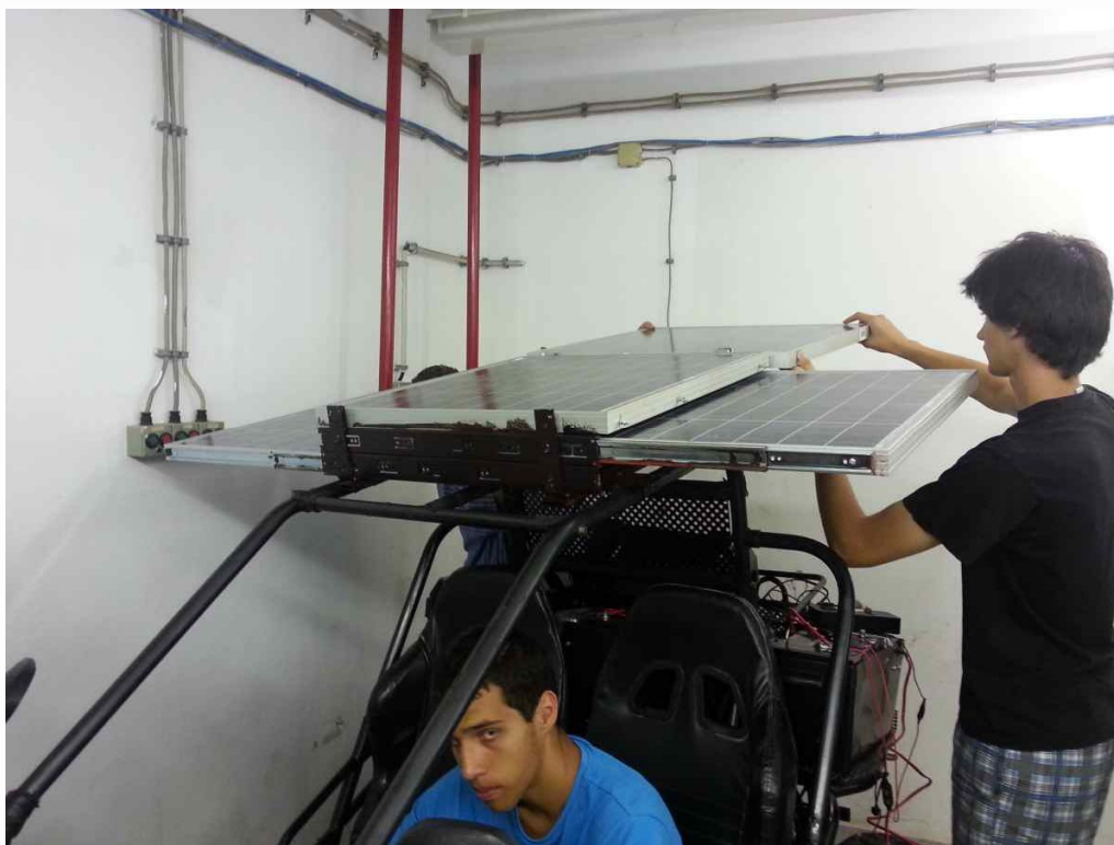
Slika 20: Ugradnja FN panela
